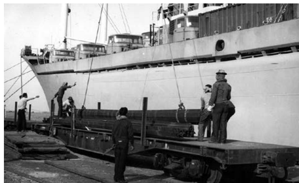
Déchargement des rails français à Kompong Som, 14 décembre 1982. IHS- CGT cheminots, Fonds J. Levart, 7 P.
